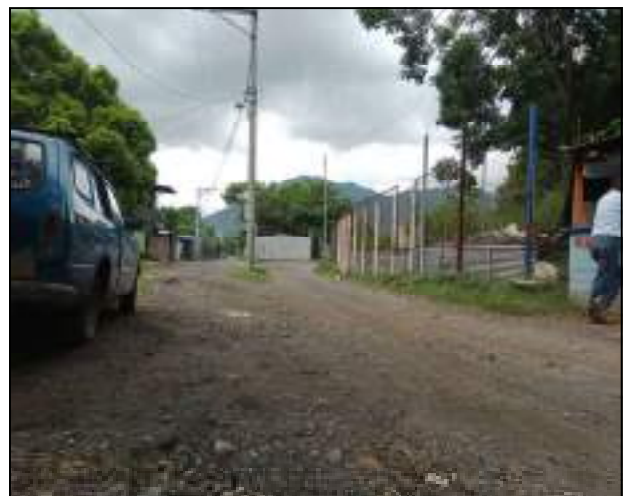
acceso costado norte
