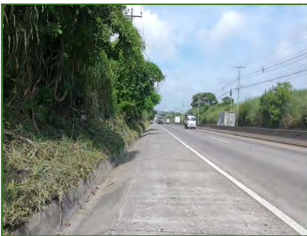
Rodaje costado Noreste (Autopista)
