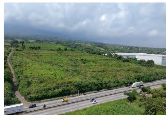
4. Fachada Oriente sobre Carretera a Quezaltepeque
