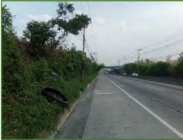
Rodaje costado Noreste (Autopista)
