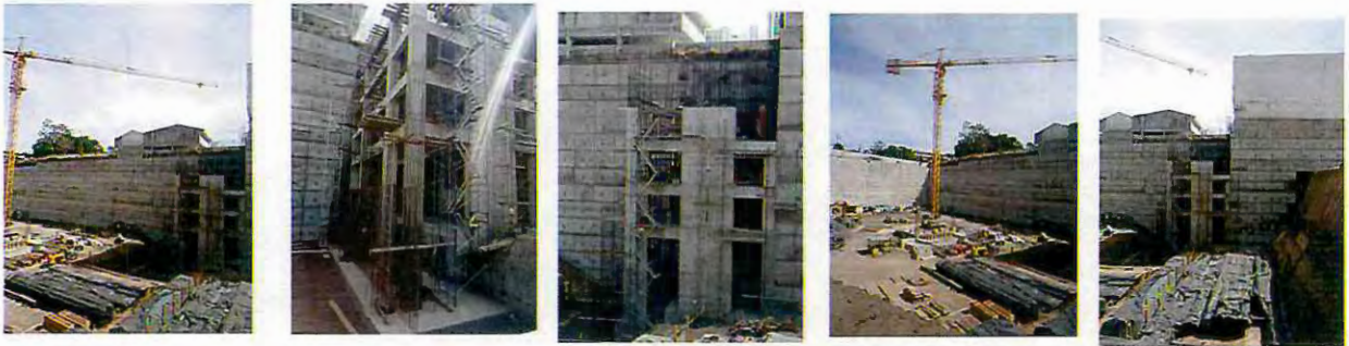
VISTAS GENERALES DEL TERRENO, OBRAS EN EJECUCIÓN DE MÓDULO, ESTRUCTURA DEL EDIFICIO
