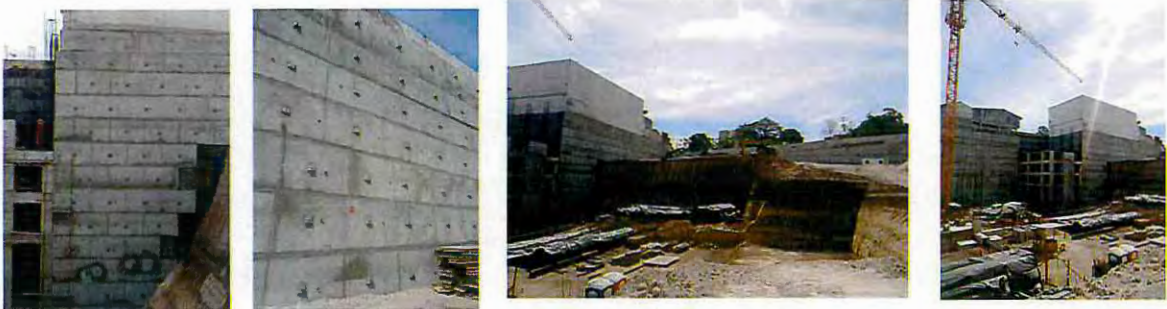
OBRAS DE TERRACERIA Y DE PROTECCIÓN AL TERRENO (MURO SOILNAILING), VISTAS VARIAS DEL TERRENO Y OBRAS EN EJECUCIÓN
